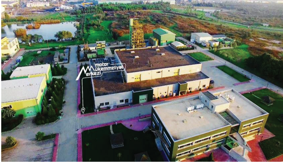
RUTE Yerleşkesinden Kesit
